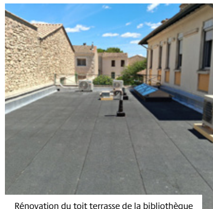
Rénovation du toit terrasse de la bibliothèque
