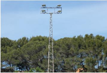
Les travaux de « relamping » en leds réalisés par la société DALKIA Electronics qui ont eu lieu au stade d'Honneur en début d'année viennent d'être réceptionnés. Six mats ont été remplacés par quatre luminaires très performants. Les produits utilisés sont de conception et de fabrication européennes, et répondent à l'ensemble des exigences environnementales. Ils vont permettre un gain conséquent sur la consommation d'électricité de l'ordre de 30 à 60% en fonction de la puissance nécessaire.
